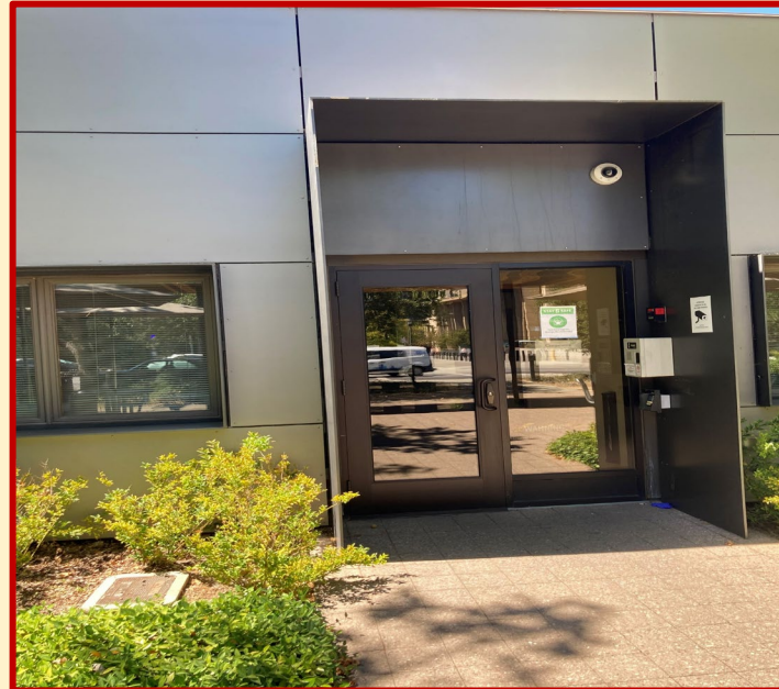
2) CMP front door
